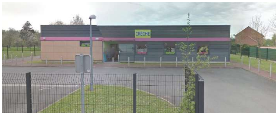
Crèche inter-entreprises située sur la Zone du Bonnel à Lallaing
