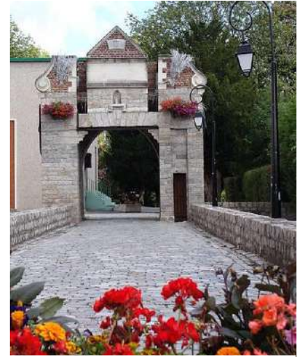
Porte de l'ancien château des Comtes de Lallaing
